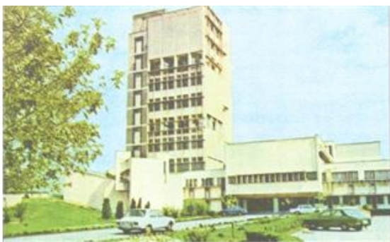
Fig. 3.1. Clădirea Facultății de electrotehnică în 1975.
