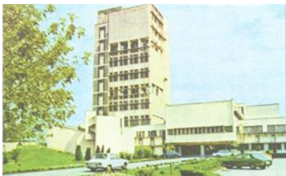
Fig. 3.1. Clădirea Facultății de electrotehnică în 1975
