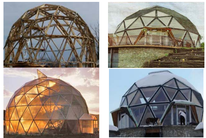
Fig. 7. Imobile construite după metoda lui Fuller în diverse stadii de execuție.
