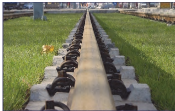
Foto 11. Elemente absorbante între firele căii.
