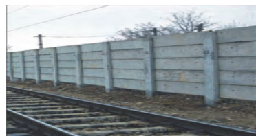
Foto 17. Ecran din beton precomprimat standard .
