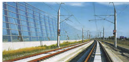
Foto 18. Ecran fonoabsorbant înalt pentru magistrale de mare viteză.
