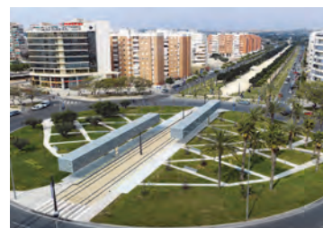
Fig. 19. Stația de tramvai Sergio Cardell Square, Alicante, din Valencia; amenaja-rea stației, după proiectul prolificului arhitect Santiago Calatrava, a fost nucleul unei operațiuni de reabilitare urbană și de transformare a unei intersecții dominată de trafic, într-un scuar care oferă și un peisaj nocturn spectaculos. Stația a devenit un simbol al orașului.
