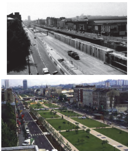
Fig. 15. Acoperirea autostrăzii A1 și transformarea ei în Bulevardul Wilson, cu un generos spațiu verde.
