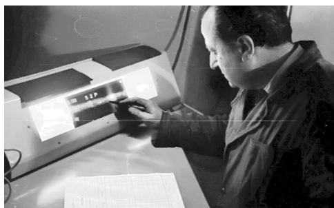
În laboratorul-dubiţă, verificând pe film sudurile.
