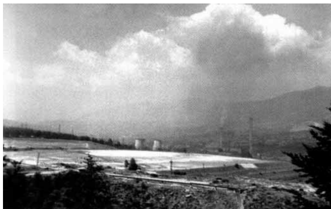
Fig. 1. Vedere generală C.E.T. Paroșeni.
