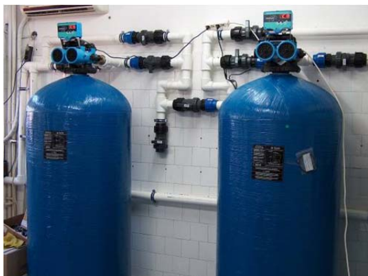
Foto 1. Filtre mecanice cu nisip și quartz în sistemul recirculant al INCDM (foto: Niță V.).
