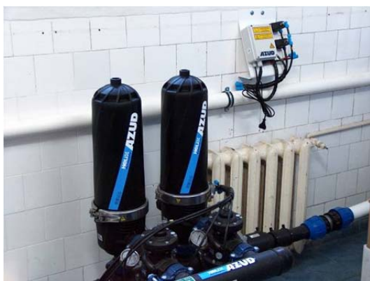
Foto 2. Cartuș filtrator automat în sistemul recirculant al INCDM (foto: Niță V.).
