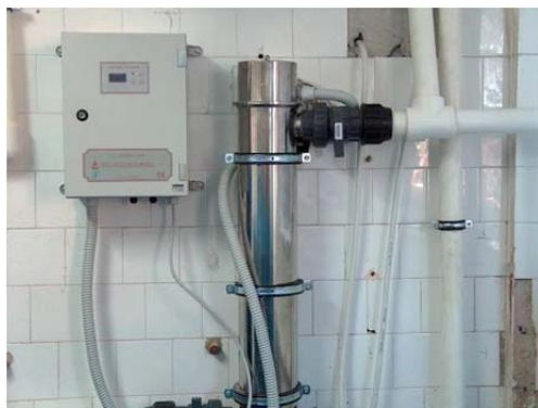
Foto 3. Unitate pentru sterilizare UV în sistemul recirculant al INCDM (foto: Niță V.).
