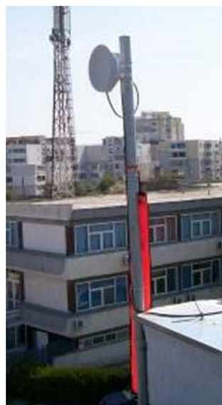
Foto 5. Sistem cu antenă de recepție a datelor măsurate fixată la baza INCMD.
