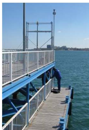
Foto 9. Pregătirea catargului pentru fixarea antenei și a senzorului de vânt
