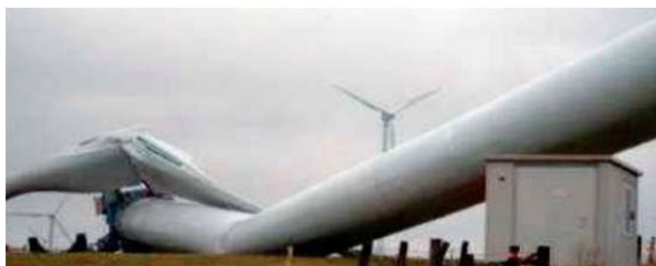
Fig. 2. Colapsul turnului de susținere al unei turbine eoliene provocat de furtună.
