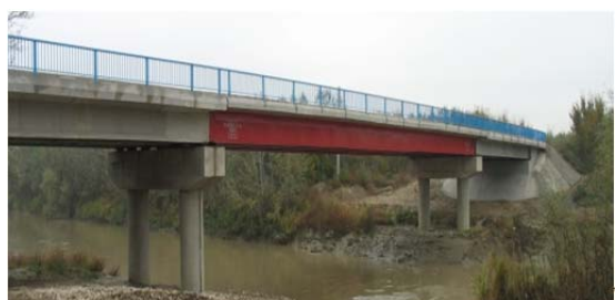
Fig. 6. Pod peste râul Ialomița.
