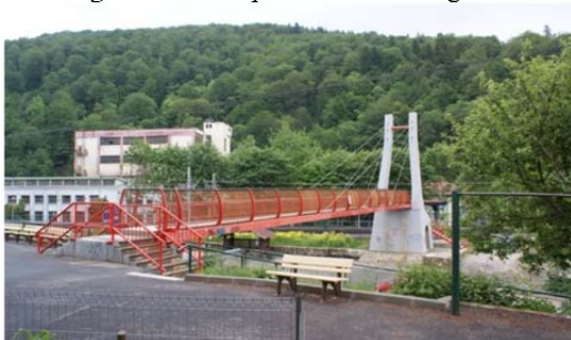
Fig. 11. Pasarelă peste DN 1 la Sinaia.
