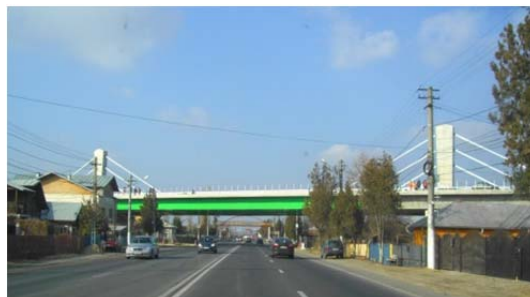
Fig. 14. Pasaj hobanat de autostradă la Bărcănești.
