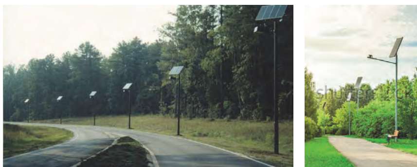
Fig.13. Sisteme de iluminat fotovoltaice utilizate pentru iluminatul aleilor parcurilor.
