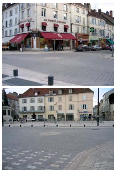
Fig. 8. Intersecție partajată ( shared-space ), înălțată, Lons le Saunier – Franța.
