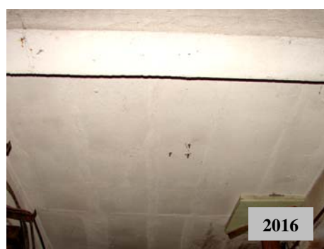
Fig. 5. Planșeu de beton armat consolidat cu mortar special de reparații [5]. Comportare bună în exploatare (zona B).
