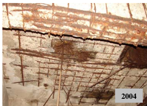
Fig. 5. Planșeu de beton armat consolidat cu mortar special de reparații [5]. Comportare bună în exploatare (zona B).
