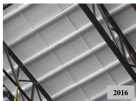
Fig. 4. Cheson de beton armat consolidat cu mortar special de reparații [2]. Comportare bună în exploatare (zona A).
