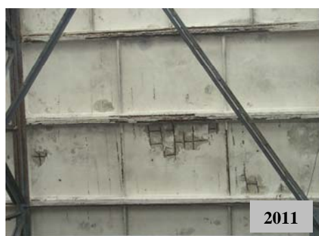
Fig. 4. Cheson de beton armat consolidat cu mortar special de reparații [2]. Comportare bună în exploatare (zona A).
