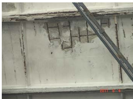
Fig. 2. Nivel mediu de deteriorare din cauze de durabilitate la cheson din beton armat, zona A (2011) [2].
