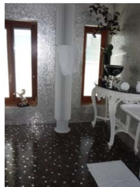
Foto 12. Finisajul la nivelul peretilor: mozaic producator BISAZZA, colectia Gold, model Queen, chit rosturi Neutro Base.
