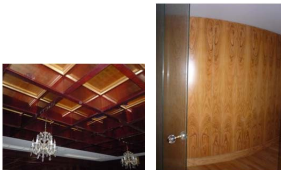
Foto 16. Finisajul determinat la nivelul peretilor si plafoanelor, de tip panou lemn, suport panouri aschii aglomerate pal/mdf, finisate cu furnir lemn exotic.
