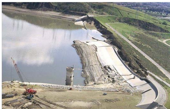
Fig. 2.3. Cedarea barajului inferior San Fernando, 1971, California, SUA.
