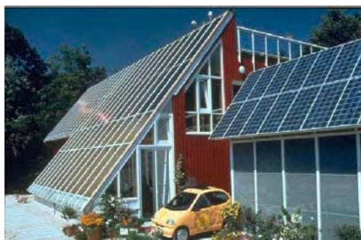
Fig. 3. Sistem PV integrat în clădiri: a) BAPV; b) BIPV [2].
