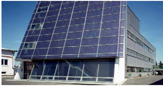
Fig. 4. Panouri PV integrate în fațada clădirii [11].
