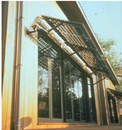
Fig. 5. Integrare PV de tip umbrar mobil [2].
