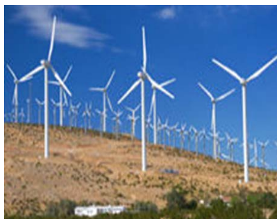
Fig. 7 Ferma de vânt „Fântânele-Cogealac”, România [23,24].
