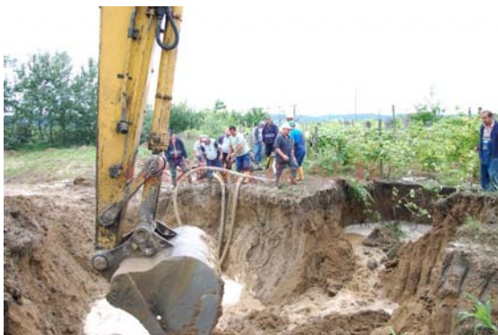
Fig. 4. Remedierea defectelor de pe conducta de aducțiune Izvarna Craiova.
