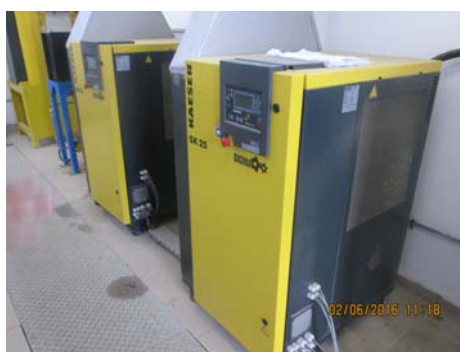
Fig. 7. Instalații de ozonare a apei.
