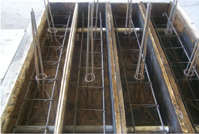
Foto 1. Cofraje fundații pentru elemente încercate la forțe V.
