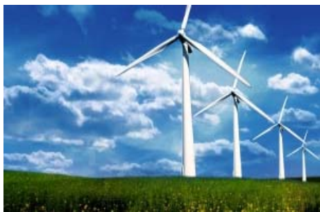
Fig. 3.1. Parc de centrale eoliene (on shore) [9].
