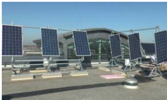
Fig. 4.2. Panouri solare fotovoltaice [13].
