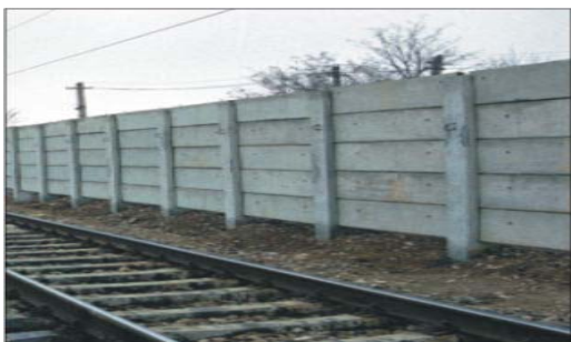
Fig.5. Ecran din beton precomprimat standard pentru stații c.f.
