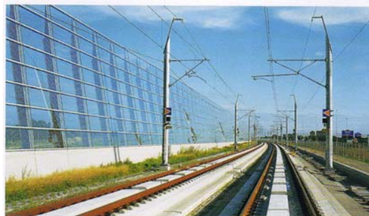
Fig. 6. Ecran fonoabsorbant înalt pentru linii magistrale de mare viteză
