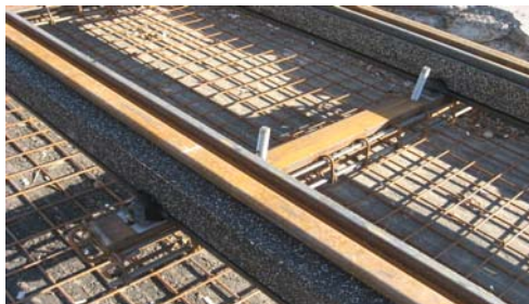
Fig. 1. Aspect al căii de rulare pentru tramvaie.
