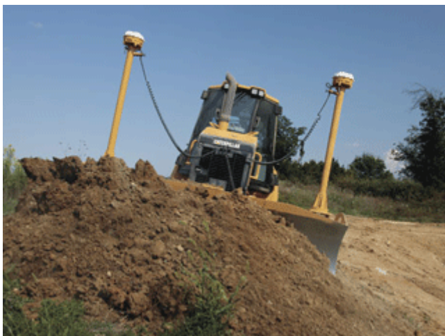
Fig. 5 Buldozer dotat cu senzori GPS [6].
