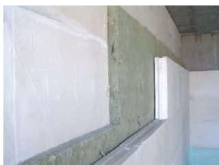
Fig. 4. Izolarea fonică și termică a clădirilor.
